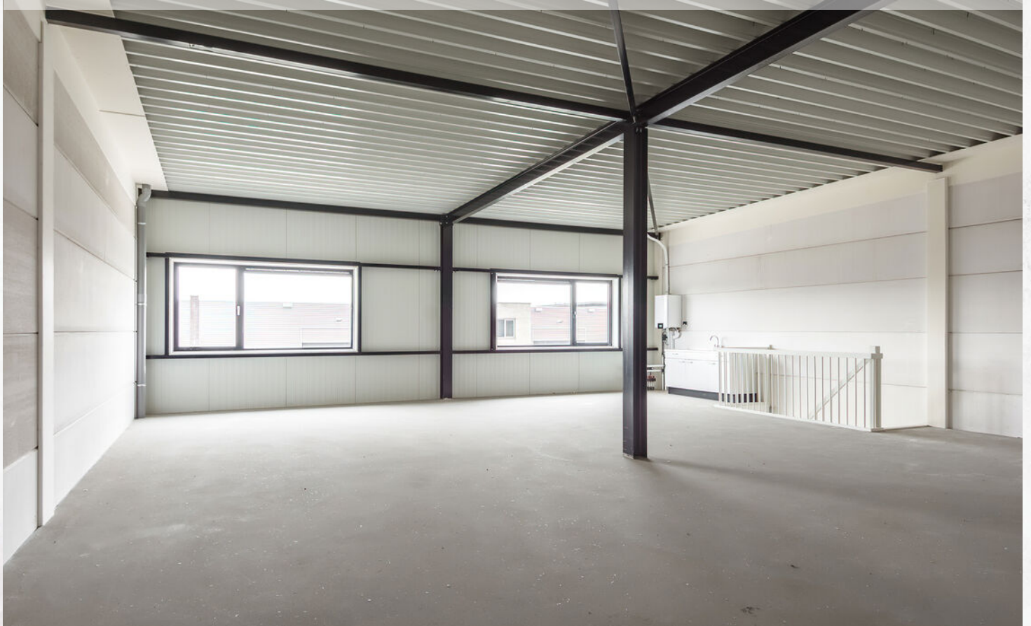
Kantoor-/ opslagruimte verdieping
