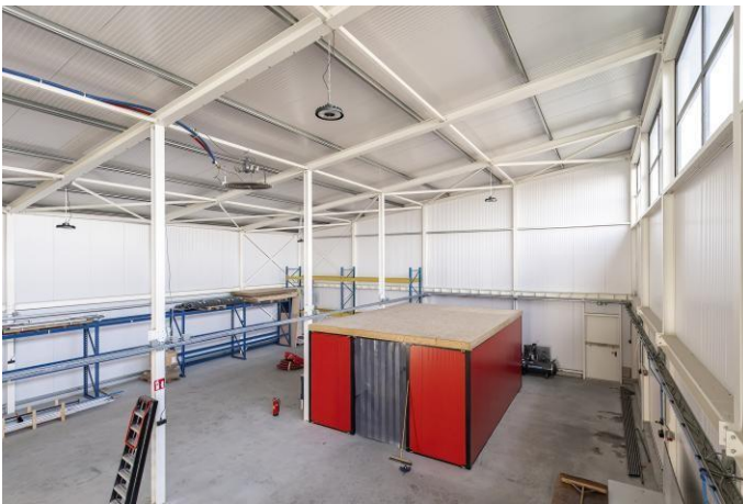
Bedrijfshal vanaf de verdieping gezien
