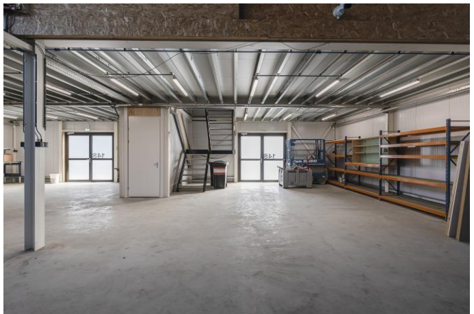
Onder de verdiepingsvloer
