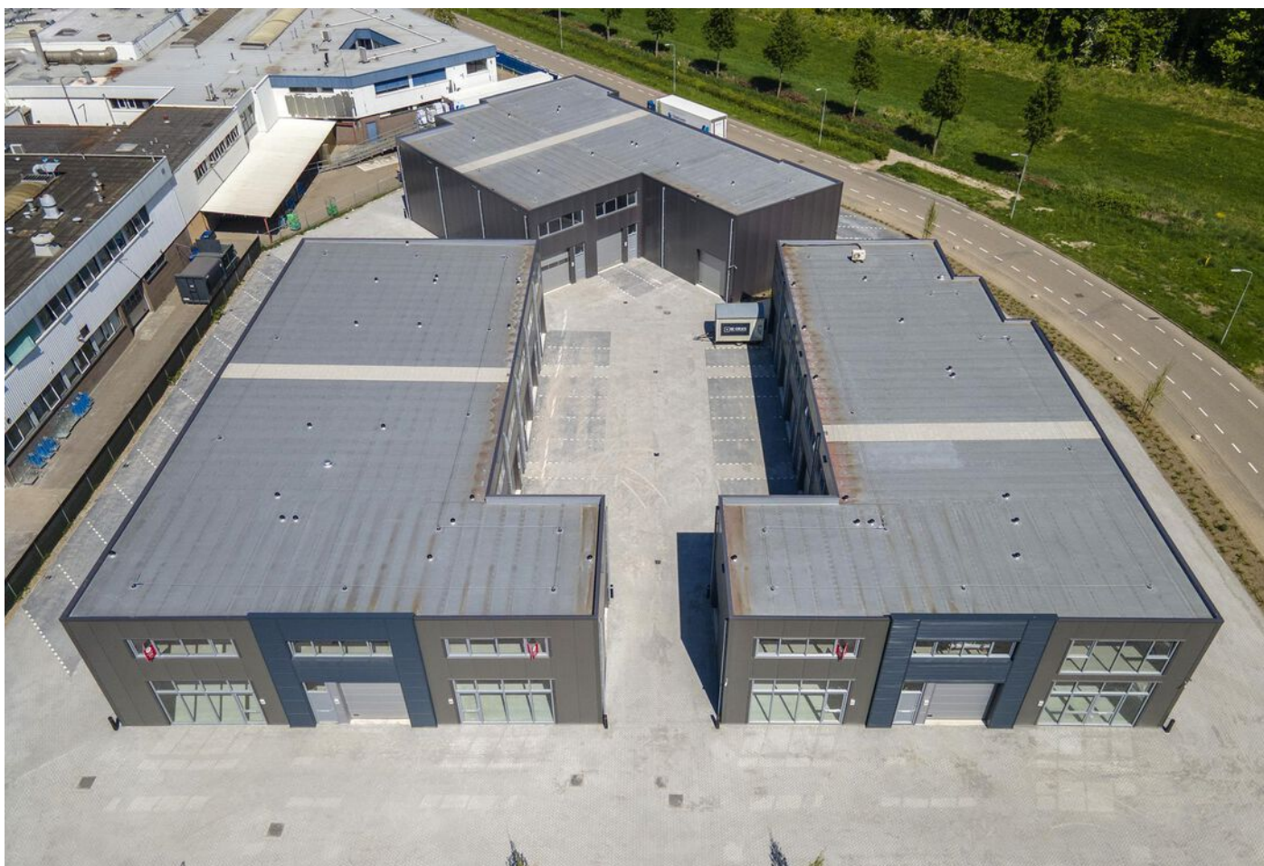
Latensteinse Middenweg 25, Tiel
