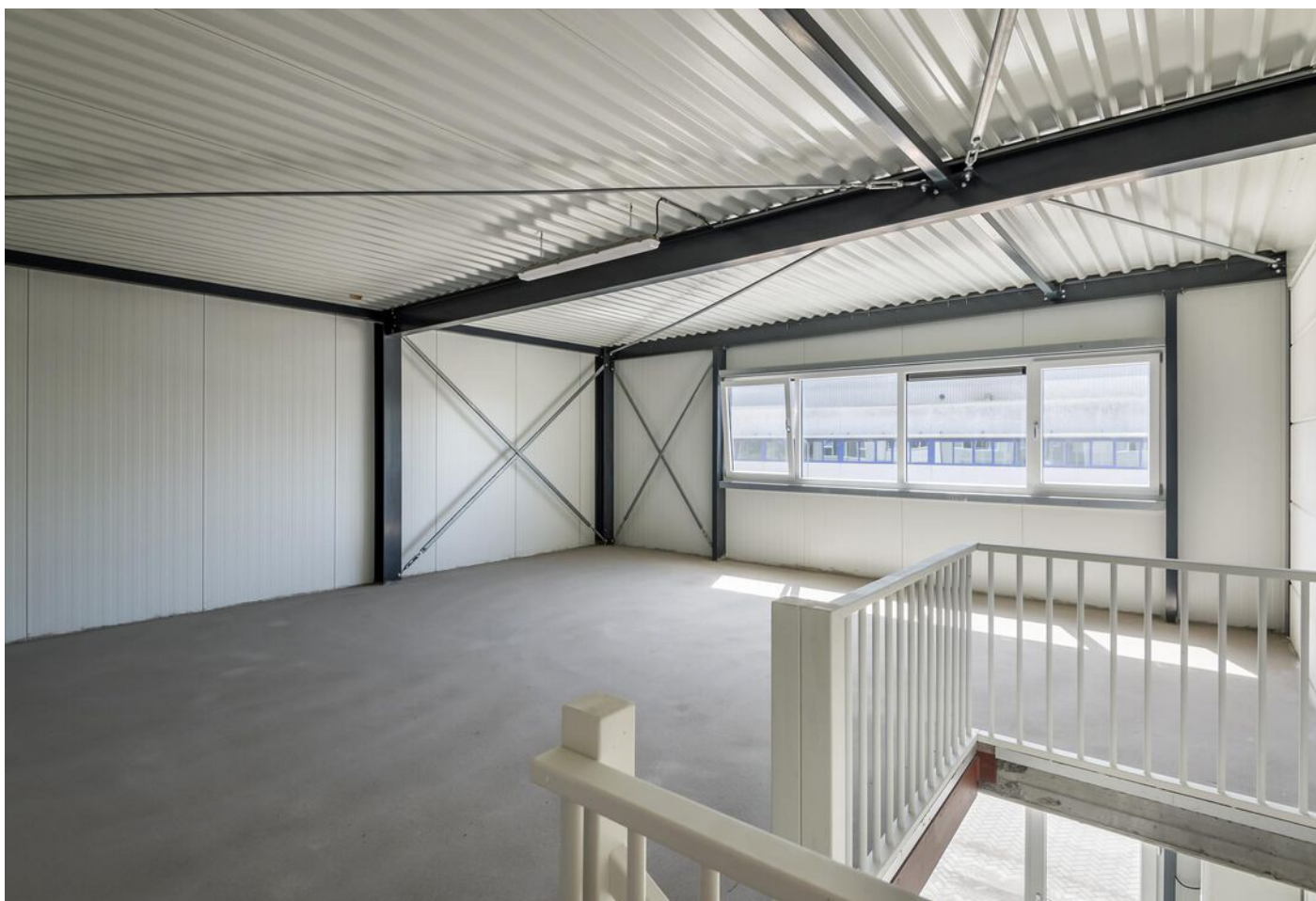
Latensteinse Middenweg 25, Tiel
