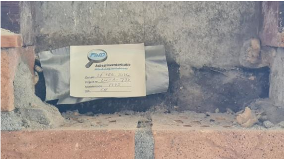
Asbestinventarisatie (rondom kozijnen)
