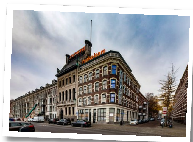
Maaskade 113, 3071 NJ Rotterdam
