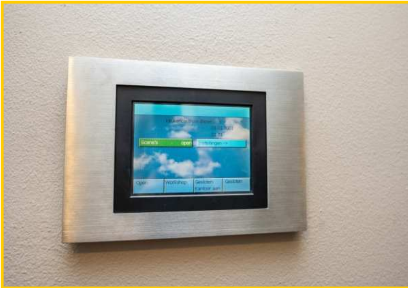
Bedieningspaneel KNX gebouwbeheersysteem.
