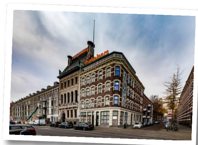
Maaskade 113, 3071 NJ Rotterdam
